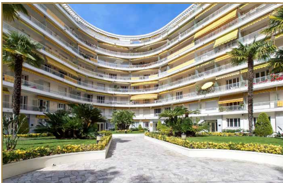
Extérieur du bâtiment
